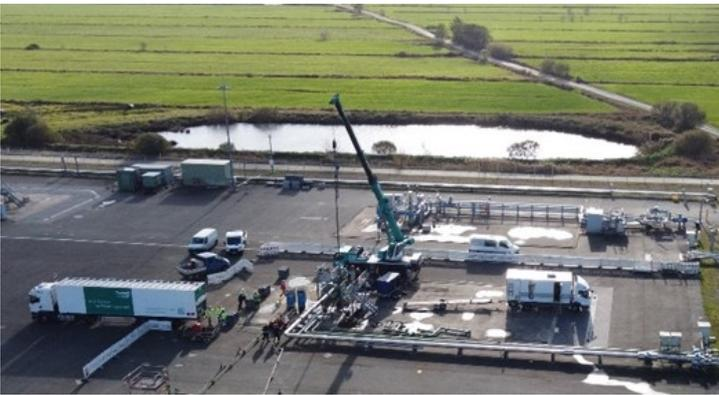
Injektion von Wasserstoff in Bohrung der Projektkaverne H2CAST im Nov. 2022 (Quelle: H2CAST Etzel)
