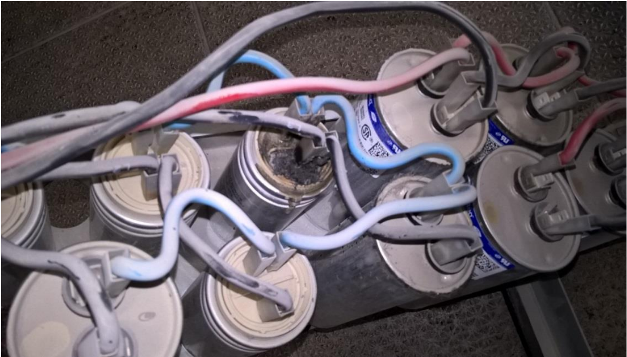
Abbildung 2: Beschädigter Elektrolytkondensator
