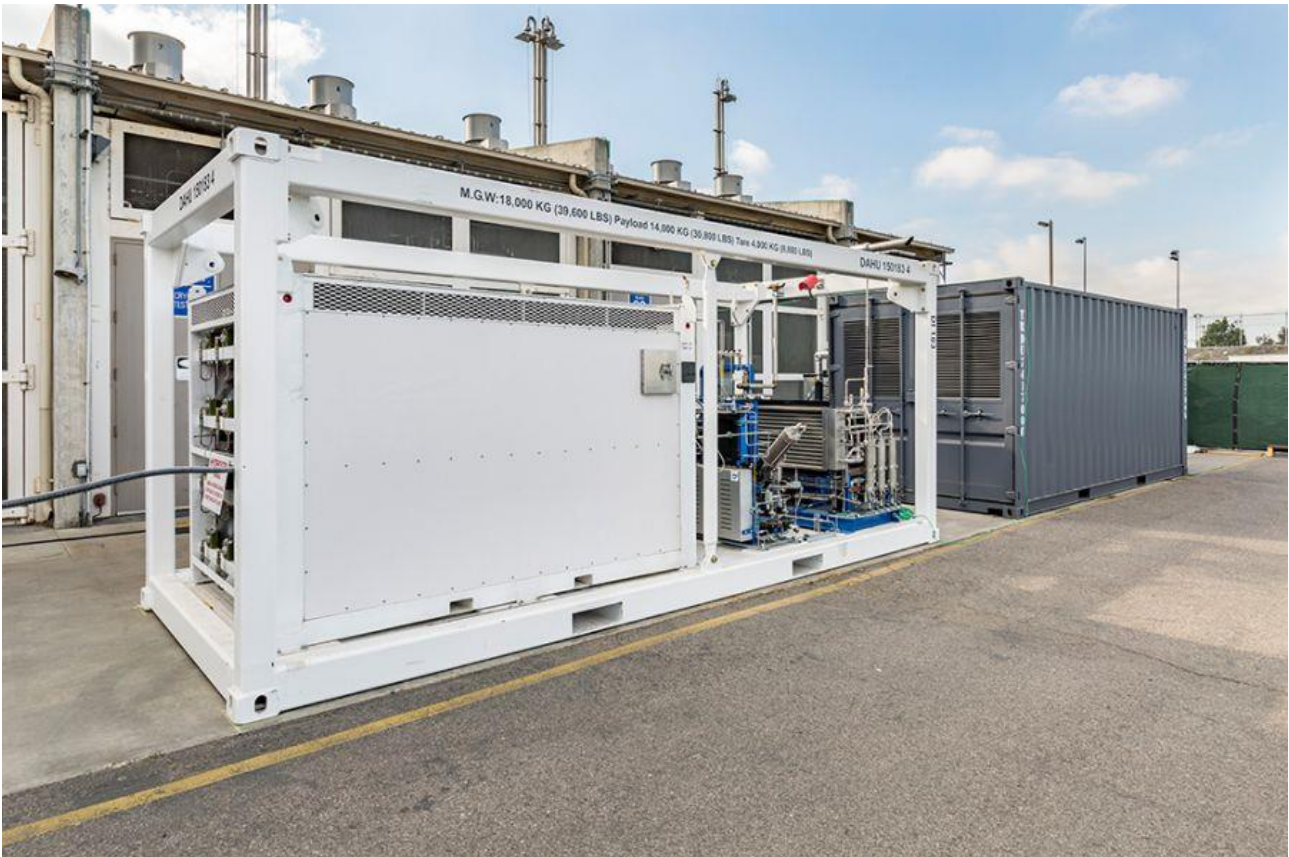
Abbildung 15: dezentrale Hochtemperatur-Elektrolyse (Bildquelle: sunfire GmbH) [34]
