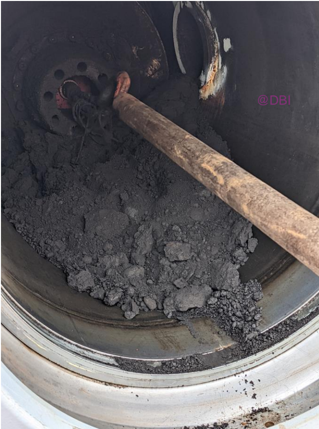
Abbildung 8: Ablagerung in Alt-Pipeline (Anm. optischer Eindruck täuscht, sehr hoher Anteil an Ölen und Kohlenwasserstoffen)
