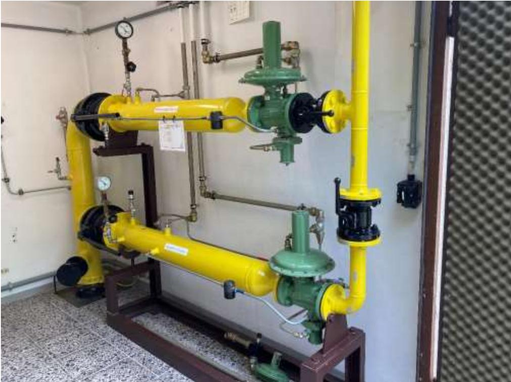
Abbildung 2: ND-Regelschienen für Messdurchführung
