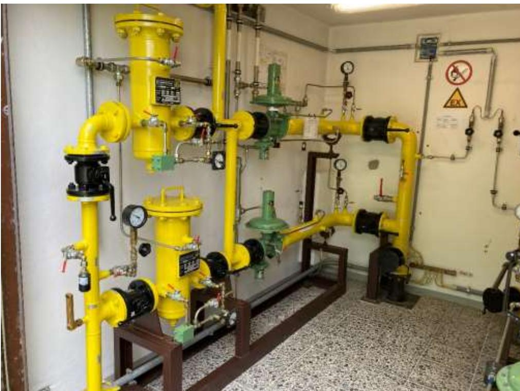
Abbildung 3: MD-Regelschienen für Messdurchführung
