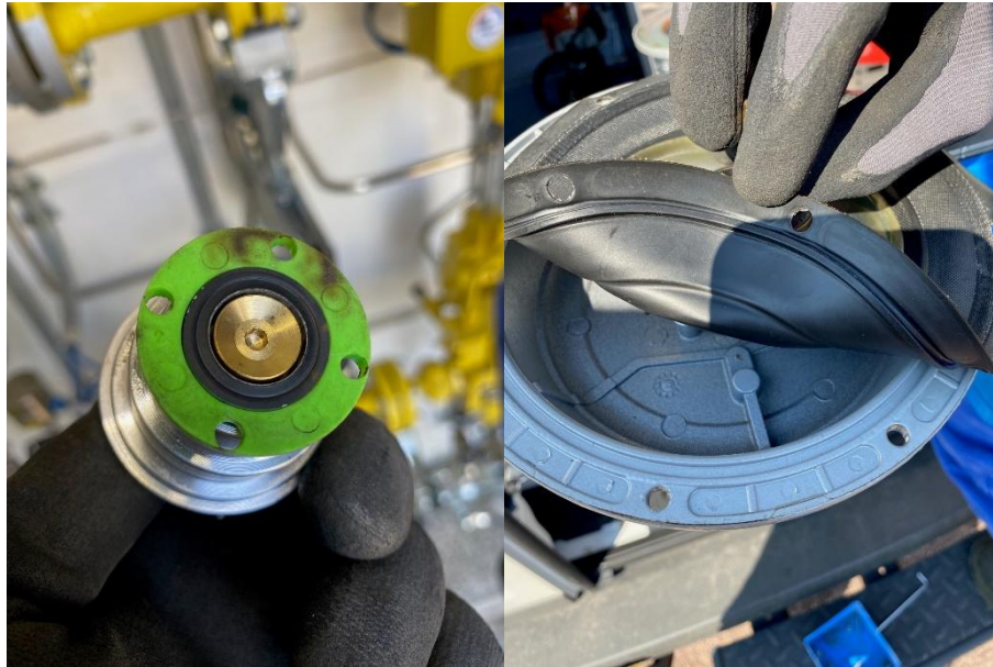
Abbildung 49: Membran Gasdruckregelgerät Schiene 1 / Schiene 3
