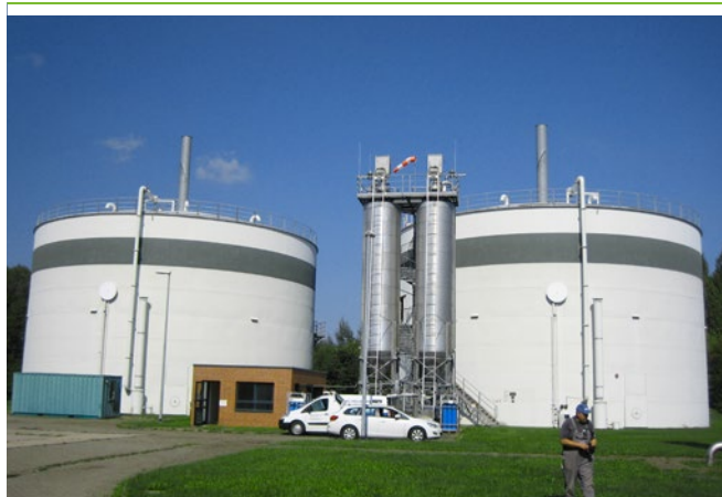
Magazyn gazu oczyszczalni Lipsk / Rosental
